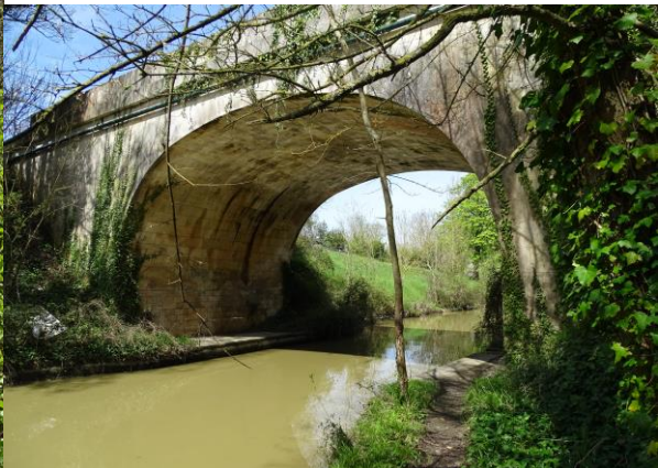
Pont de l'ancienne entrée de Marennes (2)
