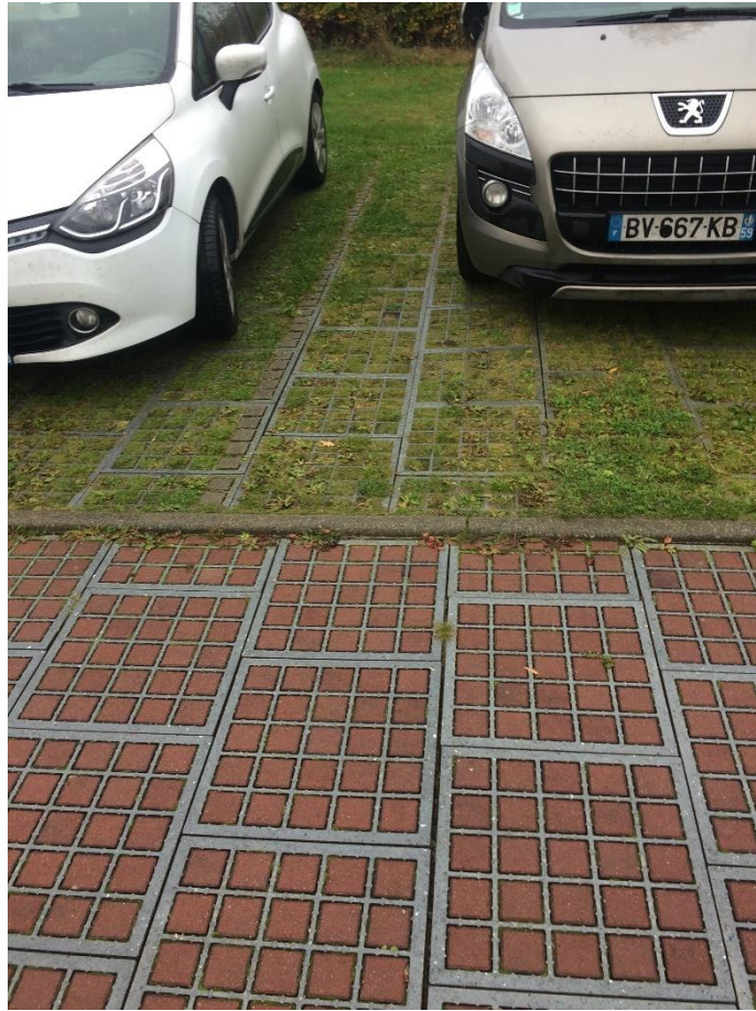
Figure 1: Exemple de revêtement modifiable permettant d'utiliser différents substrats avec la même structure
