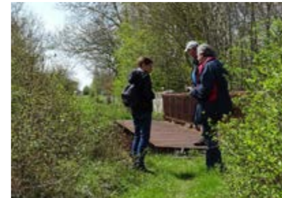
Pont de l'ancienne voie ferrée
