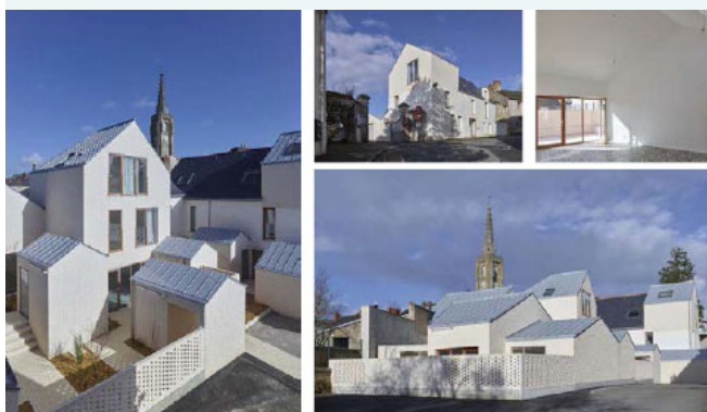
Réhabilitation et extension de 6 logements (trois T2, un T3 et deux T4) | Résidence Le Verger | Mauves sur Loire | TACT Architectes
