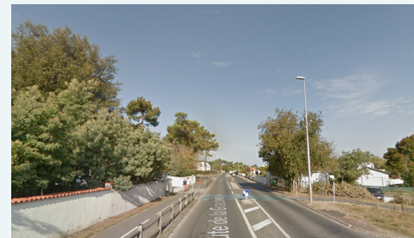
Exemple négatif / Saint-Trojan / Streetview Paysage / Vocabulaire routier / Limites marquées par des murs imperméables à la vue / paysage uniformisé Corridors biologiques / TVB / Murs imperméables ne laissant pas passer la biodiversité, axe accidentogène.
