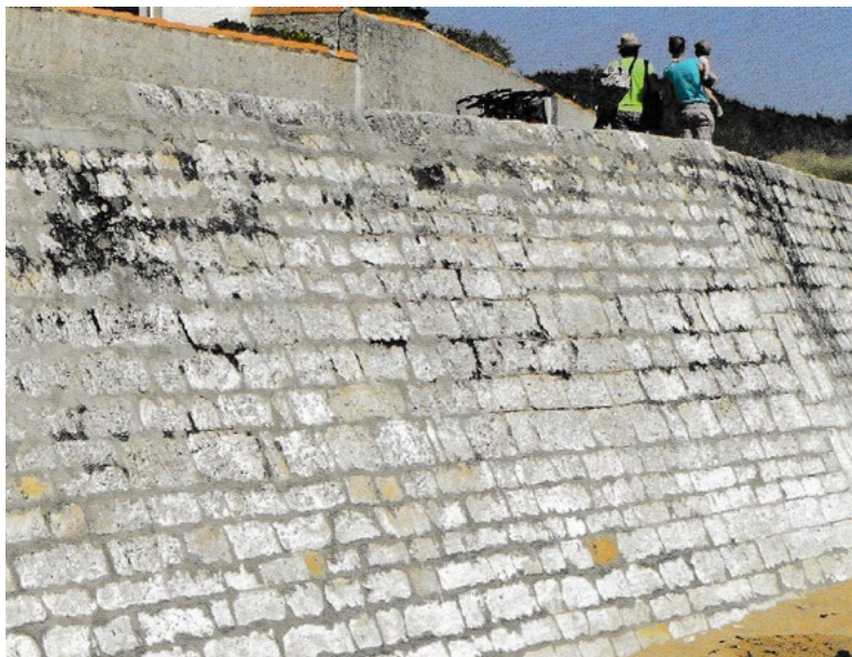
MUR DE PROTECTION AU NORD DE PERROCHE
