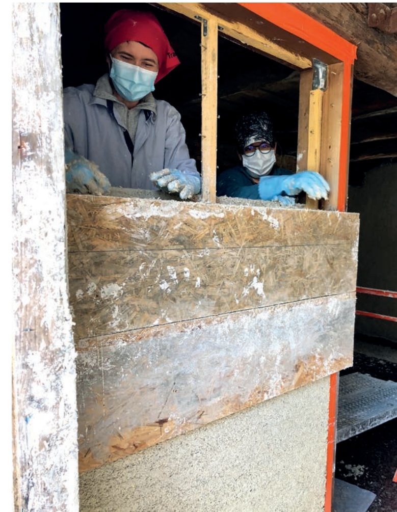
Formation écomatériaux : cloison chaux-chanvre.
