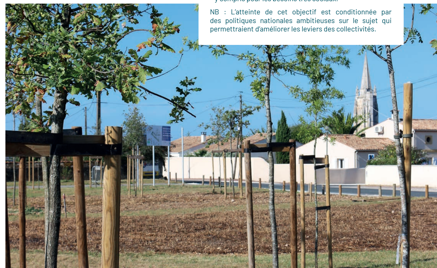
La Marquina - écoquartier en construction à Marenes - 2021.
