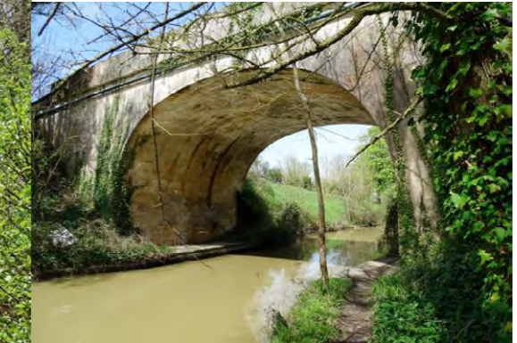
Pont de l'ancienne entrée de Marennes (2)
