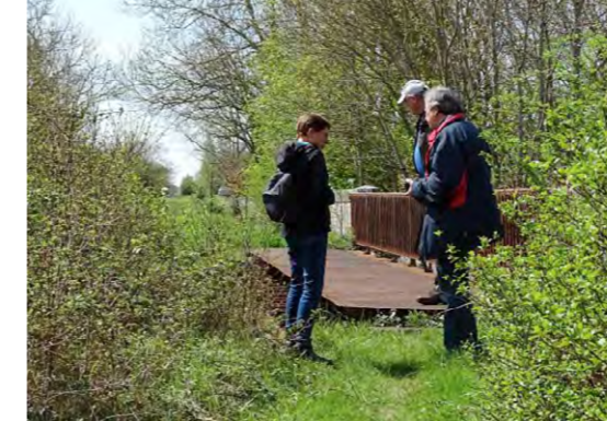
Pont de l'ancienne voie ferrée
