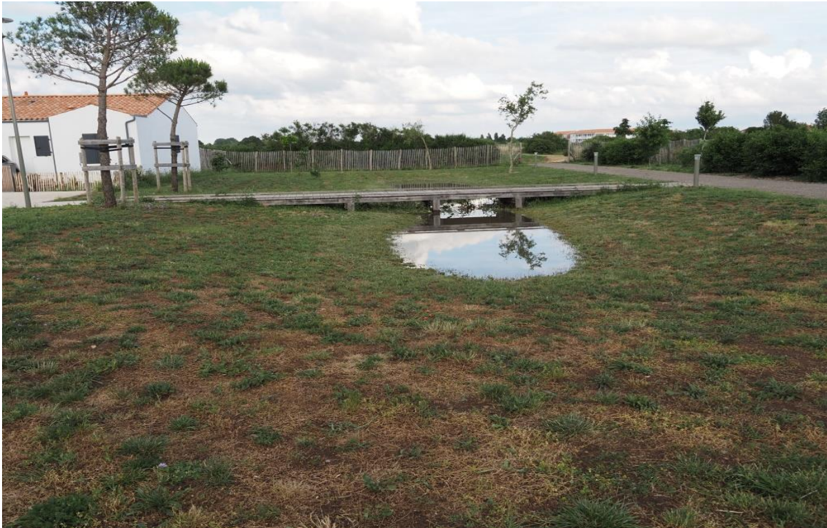
Marenes, écoquartier récent de « La Marquina » : en bordure de lotissement, des noues (ici au lendemain d'un fort orage d'été), et un accès pédestre direct à une zone plus naturelle. © : IODDE
